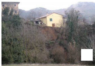
LA FRANA DI ANCAIANO DI SPOLETO
